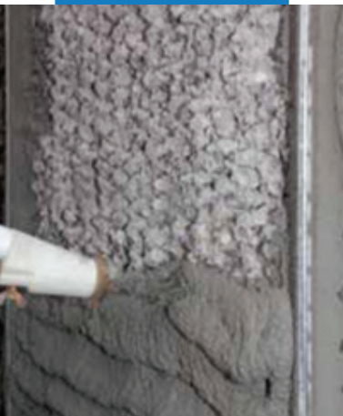
Нанесение Марегрут 230 ( Малеграут 230 ) набрызгом
