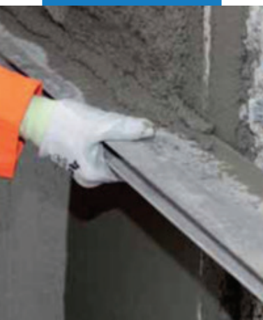
Выравнивание Марегрут 230 ( Малеграут 230 ) при помощи правила
