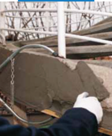
Нанесение Марегрут 230 ( Малеграут 230 ) при помощи мастерка
